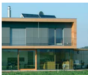
Sur toiture plate
