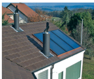
Sur une toiture inclinée ou intégrés dans la toiture
