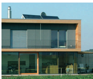
Sur toiture plate
