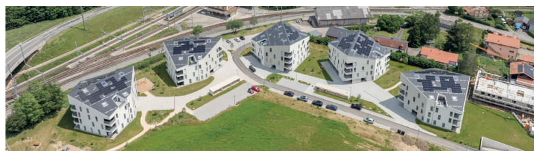
Le contracting solaire est également proposé dans le cadre d'un micro-réseau électrique (microgrid), à l'exemple de ce quartier au Day, un projet Orlati.
