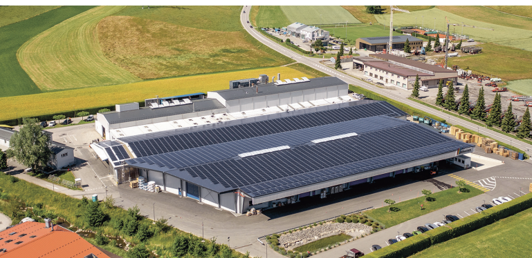
Près de 5'700 m 2 de panneaux solaires ont été posés sur les toits de Metalcolor à Forel, couvrant l'équivalent de la consommation électrique de plus de 300 ménages par an.
