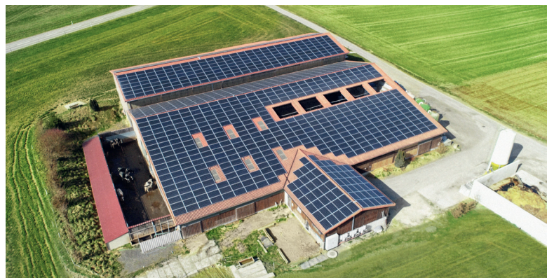
La ferme de la Fenetta, à Delley, a opté pour une installation en contracting et bénéficie ainsi d'électricité renouvelable à prix attractif.
