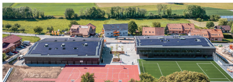
Le collège Gustave Roud à Carrouge a valorisé sa toiture en posant 2'300 m 2 de panneaux solaires photovoltaïques.
