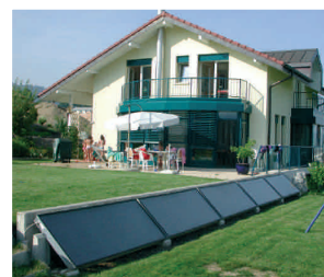
Sur talus ou au sol
