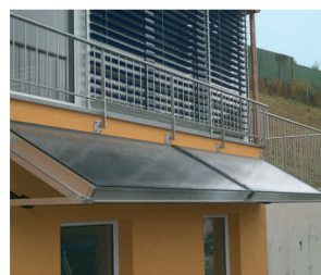
Sur façade ou balcon
