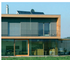
Sur toiture plate
