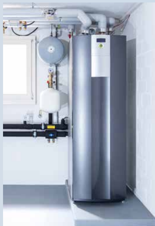
WZSV avec réservoir d'eau chaude intégré de 178 litres
